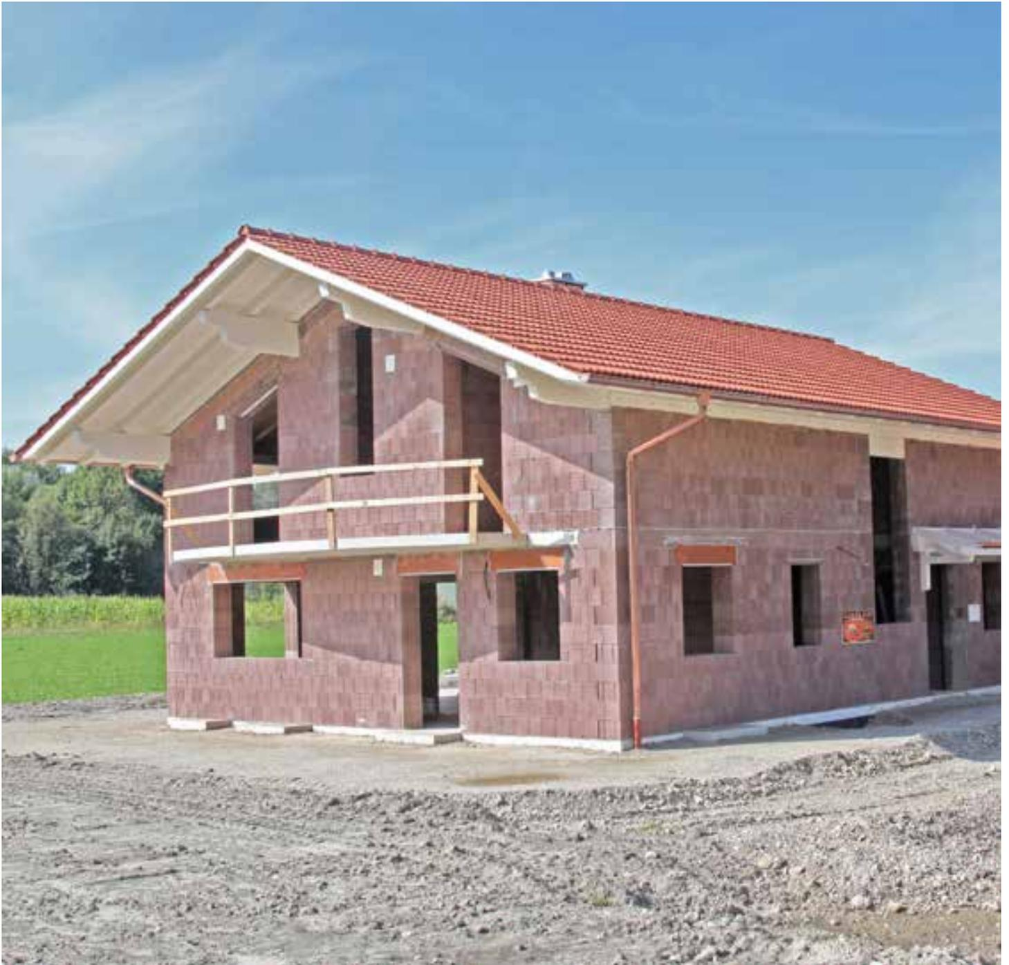
Diese Steine sind echte Kombinationstalente. Sie verbinden die guten wärmedämmenden und wärmespeichernden Eigenschaften des Lias-Tons mit der zusätzlichen Airpop-Dämmung, die werksseitig in die Ultra Steine verfüllt wird.
